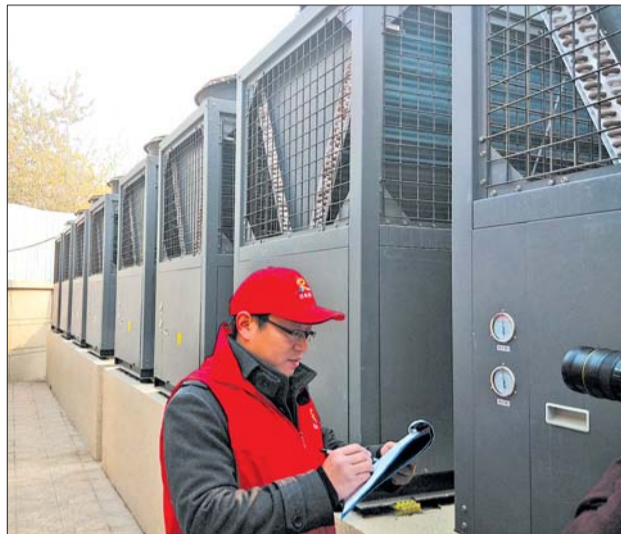
热力公司工作人员在监控记录空气源热泵运行数据。 本报记者 蒋龙龙 摄
