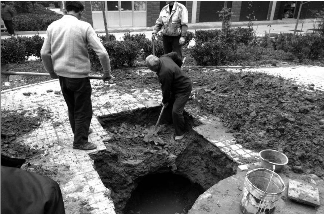
► 物业维修人员正在开挖地面,寻找漏点。本报记者路帅 摄
