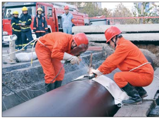
抢修队员封堵假想管道“泄漏点”。
