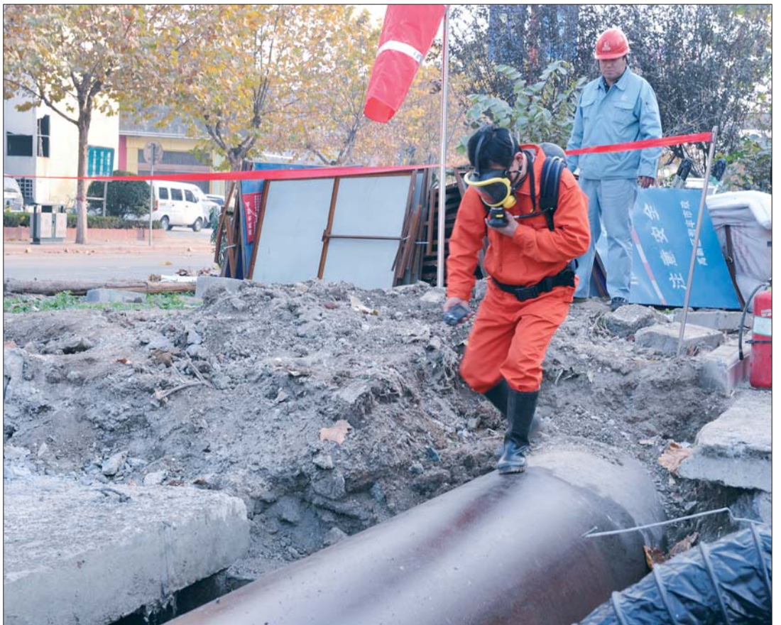
抢修队员检测油气浓度。
