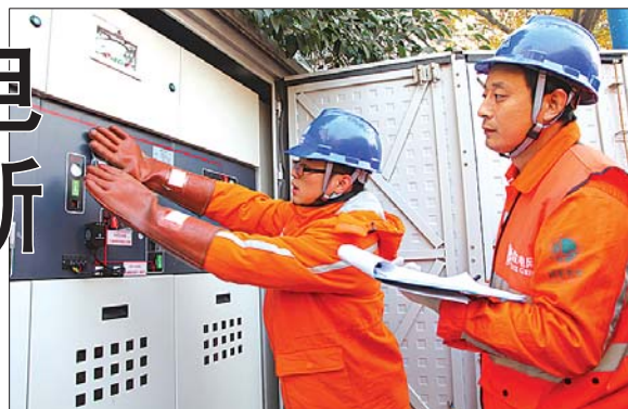
工作人员进行施工。 本报通讯员 摄
