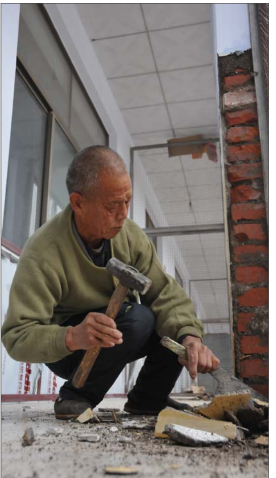
受助者在托养中心帮助工作人员装修房间。
