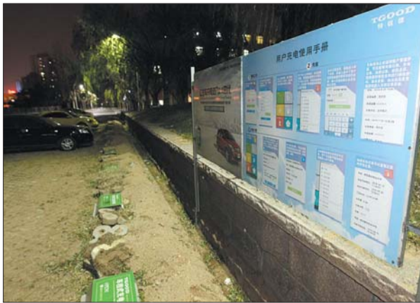
3日,在青岛大学中心校区,新安装了电动汽车充电设施。 本报记者 张晓鹏 摄
