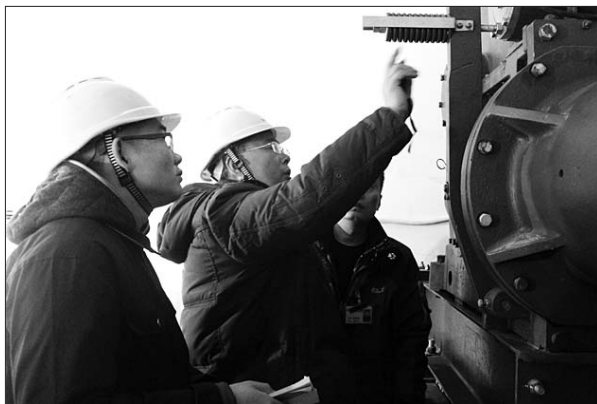
特检院检验人员正在检查电梯设备。本报记者 高雯 摄
