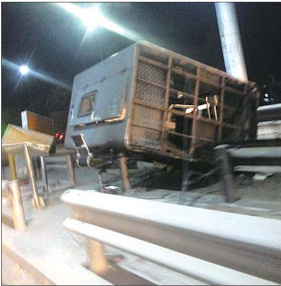
220国道曲堤收费站,被货车拽倒的收费亭。 网友供图
