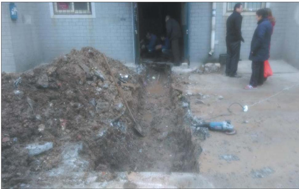
维修暖气管道掘开的沟。
