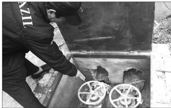
小区外围管道还未跟院内接通。 本报记者 张晶 摄
