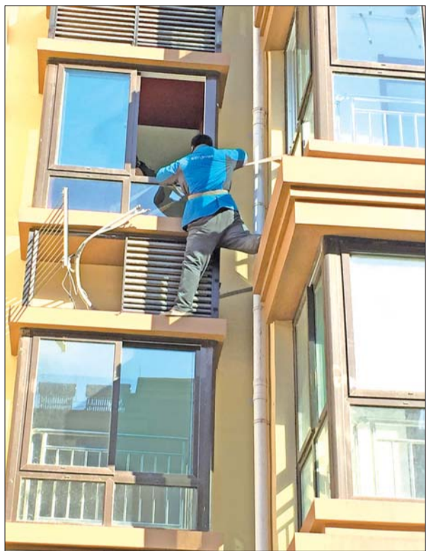
乔列明在三楼安装空调外机。 见习记者 邢敏 摄
