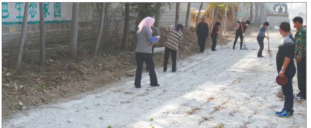
工作人员积极施工,确保工程按时完成。
