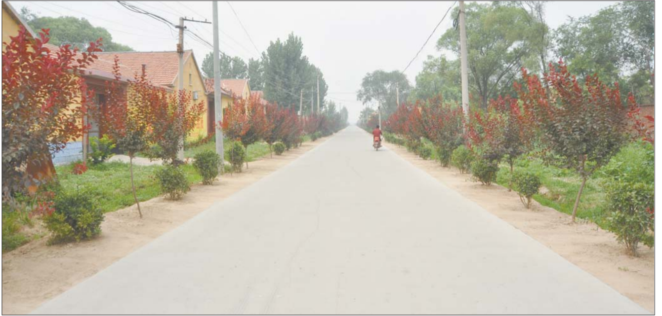
村级公路的修建改变了村容村貌。
