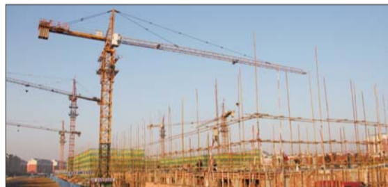
正在建设的幸福城社区。
