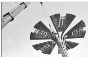
19日,烟台火车站广场高杆LED灯节能改造工程完成,夜间广场将更加美观明亮。根据当今照明发展形势,市政养管处采用节能率高、寿命长的LED灯替换原先高压钠灯,虽然数量减少,但照明强度及亮度等指标均优于原先高压钠灯。
