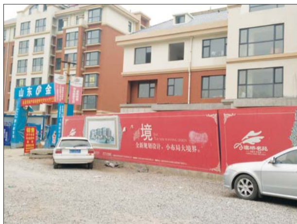
建桥名苑小区外围建设仍未完工。 本报记者 李超 摄
