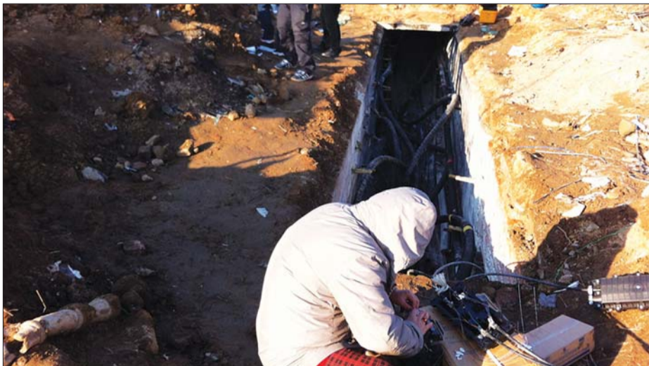
电缆沟被挖开,供电公司工作人员正在抢修设备。 本报记者 于飞 摄
