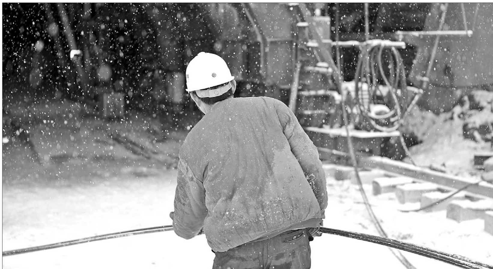
▲12月的威海寒风阵阵,后峰西隧道工人的衣服却被汗水和雪水浸湿。
