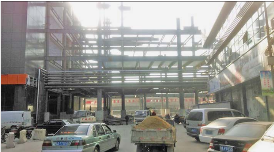
农民工跳楼讨薪的工地是一处三层二十多米高的钢架结构。 见习记者 李阳 摄
