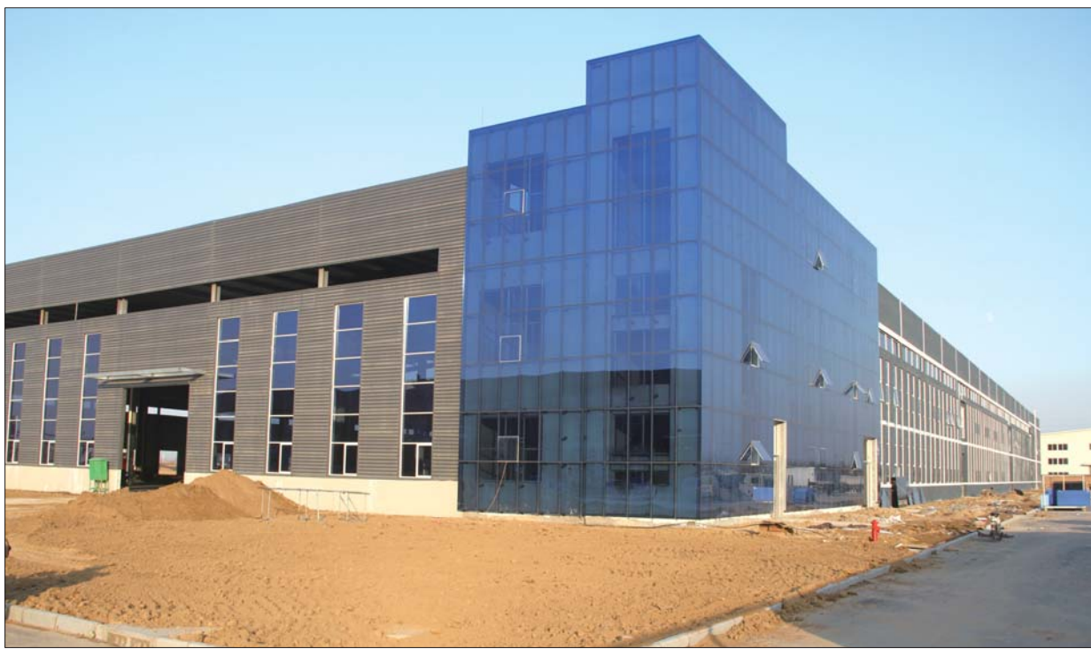
正在建设的中欧科技园。
