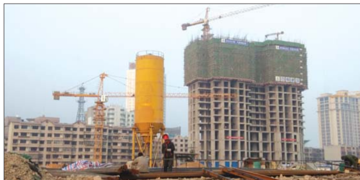
财源街改造工程的回迁楼项目已经开工建设。
