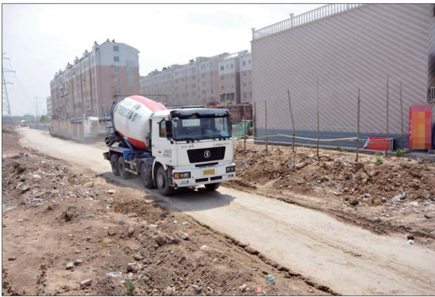
淄博对建筑工程不打招呼、直奔现场的检查将成为常态(资料片)。 本报记者 王鸿哲 摄
