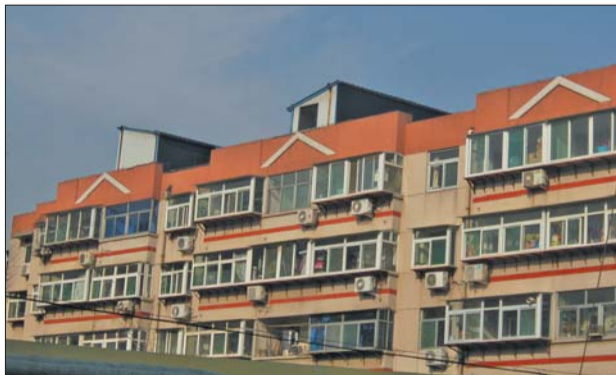
楼顶上,业主搭建了不少板房。
