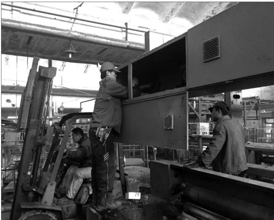
在车间内,几名工人正在对印染设备进行拆除。本报记者 庄子帆 摄
