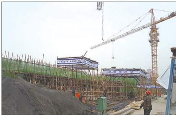
明府城一期——百花洲片区施工现场。
