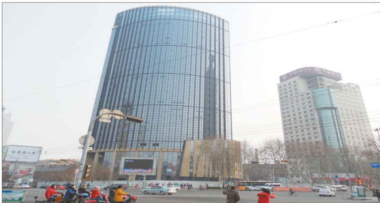
国际财富中心项目进展顺利,将与旁边的华夏银行济南分行一起成为市中金融发展的重要载体。 本报记者 张九龙 摄
