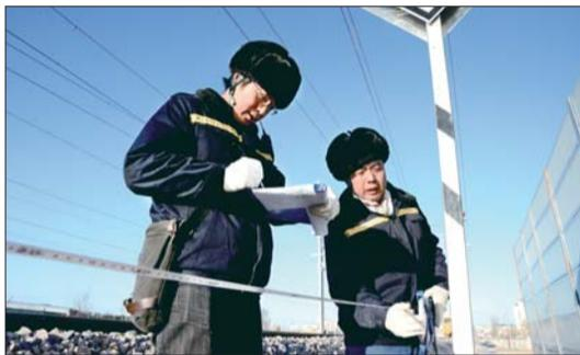
为确保青荣城际铁路烟荣联络线和青烟直通线2月份按期开通,青岛供电段督导施工单位加快供电设备缺陷整治进度,及时消除影响开通的设备安全隐患,同时对线路上的行车运行标示与接触网支柱的距离进行测量,确保达到规定要求。图为烟台南接触网工区职工测量断电标到接触网支柱间的距离。 张汝峰 弭远波 摄
