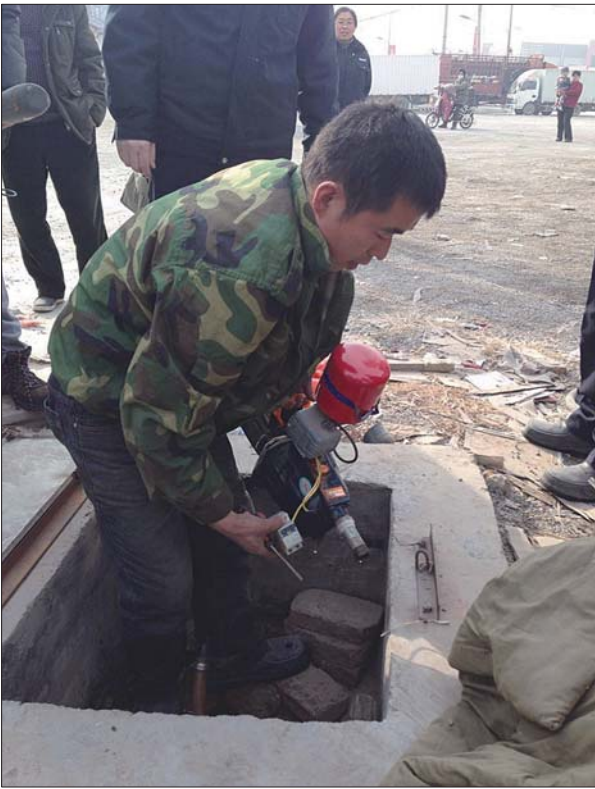
水政监察执法人员封闭洗车店乱采地下水的浅水井水泵。 本报记者 蒋龙龙 摄
