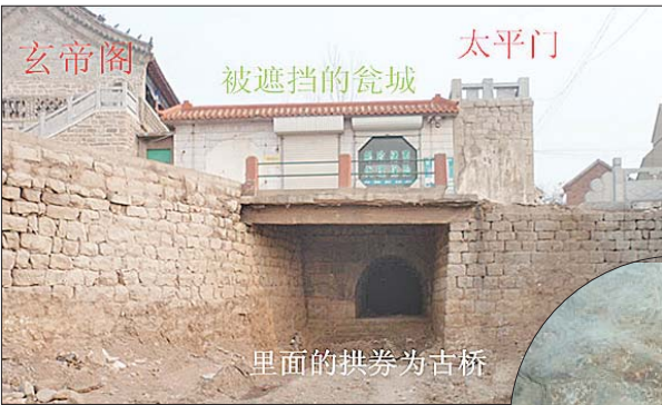
大图为“立交桥”图解，小图为券顶蚩尤头像。
