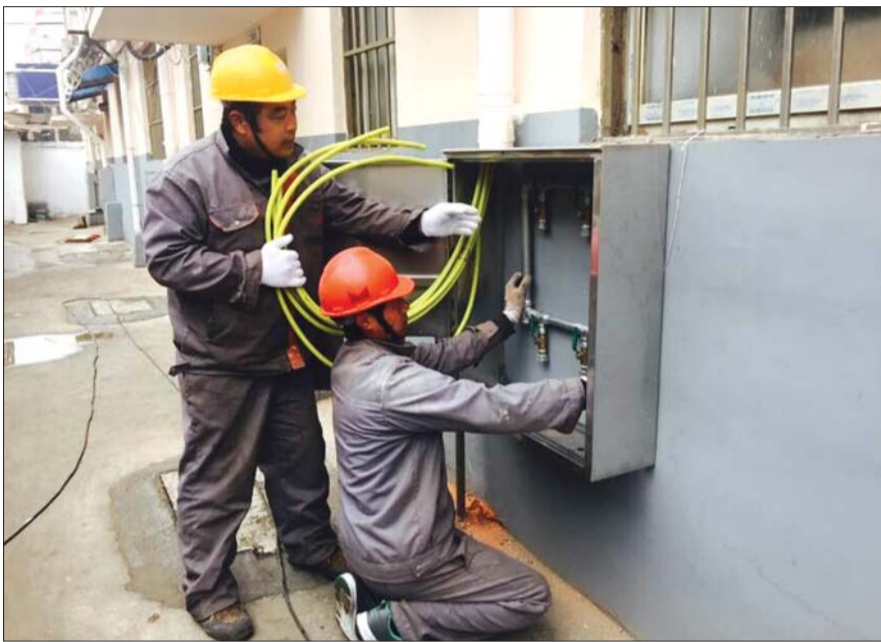
施工人员正在架设外部燃气管道。 本报记者 康宇 摄
