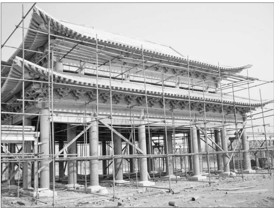
中华水上古城东南片区,复建的铁公祠主体基本完工。 本报记者 杨淑君 摄
