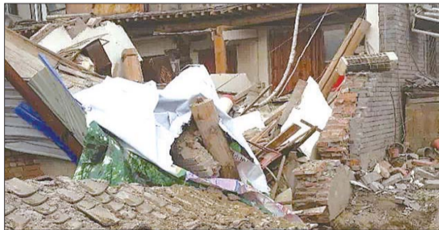
德内大街93号院坍塌现场。北京日报发
