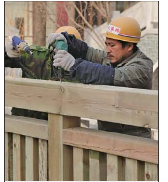
工人在紧张施工。
