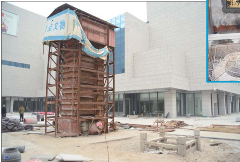
▲施工封闭前的舜井。(资料片)
