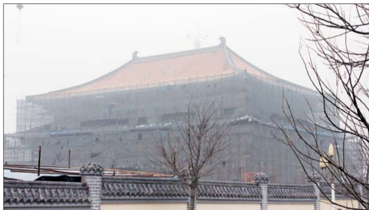
护国隆兴寺大雄宝殿主体完工。
