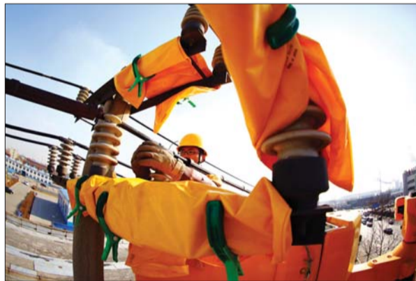
工作人员正在带电更换10千伏瓷瓶。 本报记者 王鸿哲 摄
