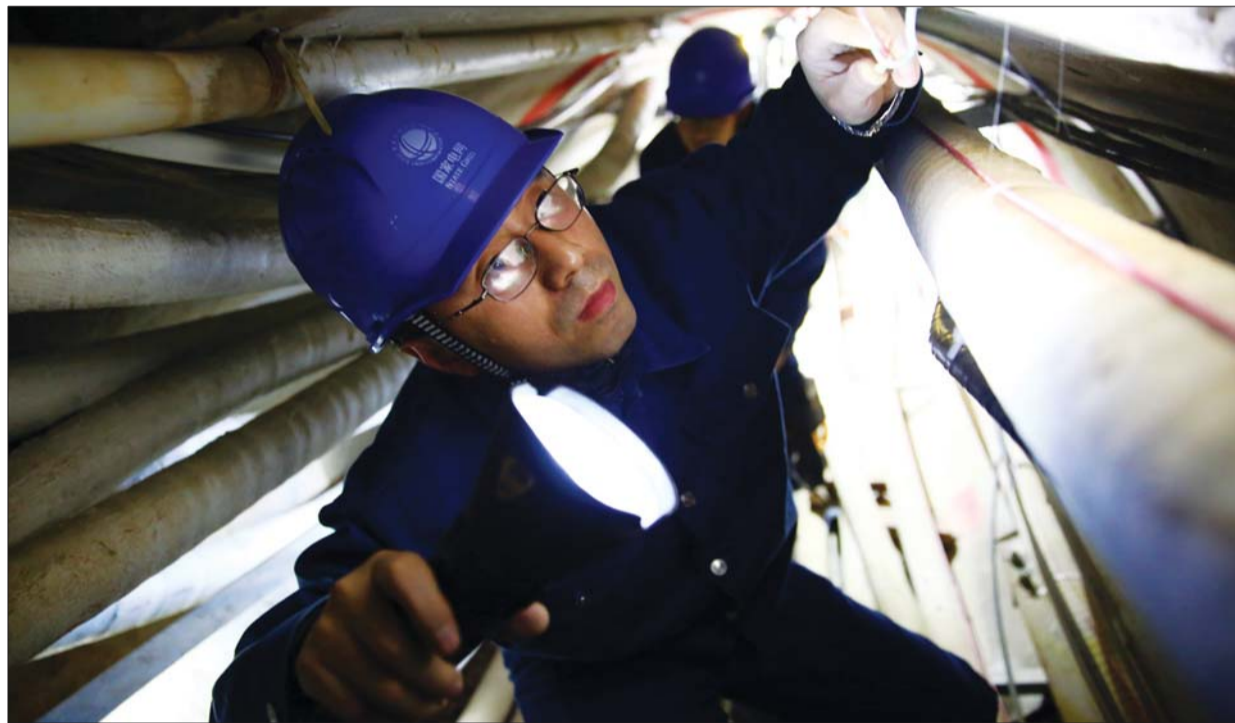
工作人员在张店城中变电站110千伏电缆隧道内进行电缆巡视。 本报记者 王鸿哲 摄
