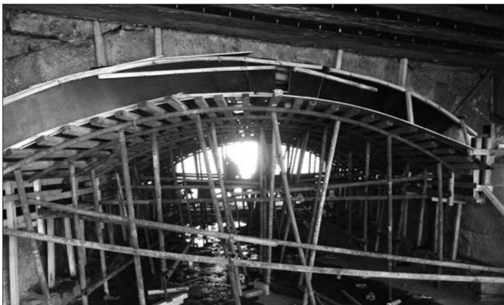
施工人员正在用钢板和复合钢筋混凝土拱圈对桥梁进行加固。 本报记者 张召旭 摄
