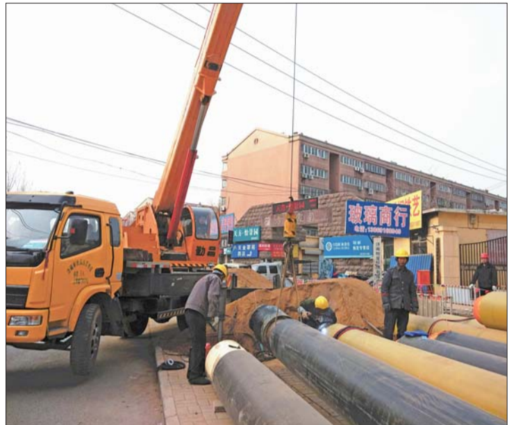
热电工作人员正在白马山南路沿线施工。
