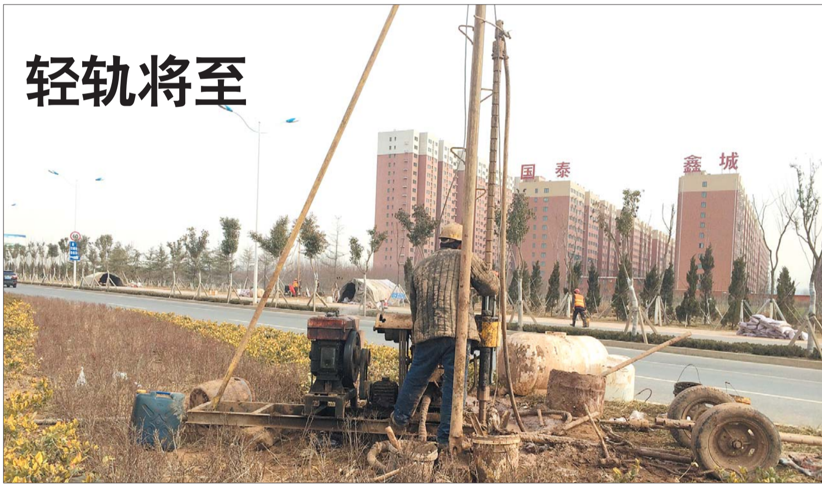
1月29日上午,济南西到长清城区的R1轻轨线路钻土勘探工作进展顺利,从南部一路向北,钻机已经钻探到了刘长山路延长线。轻轨时代距离长清越来越近。
