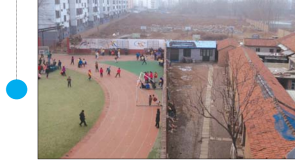
实验二小扩建工程。本报记者 梁越 摄
