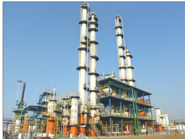
山东能源枣矿集团正在建设中的15万吨苯加氢项目
