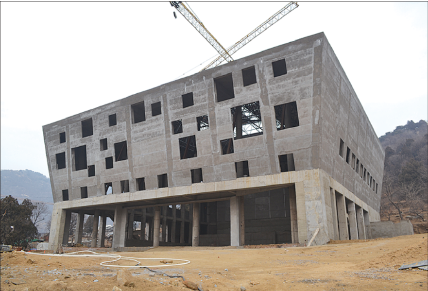
白马禅寺复建工程主体已完工。
