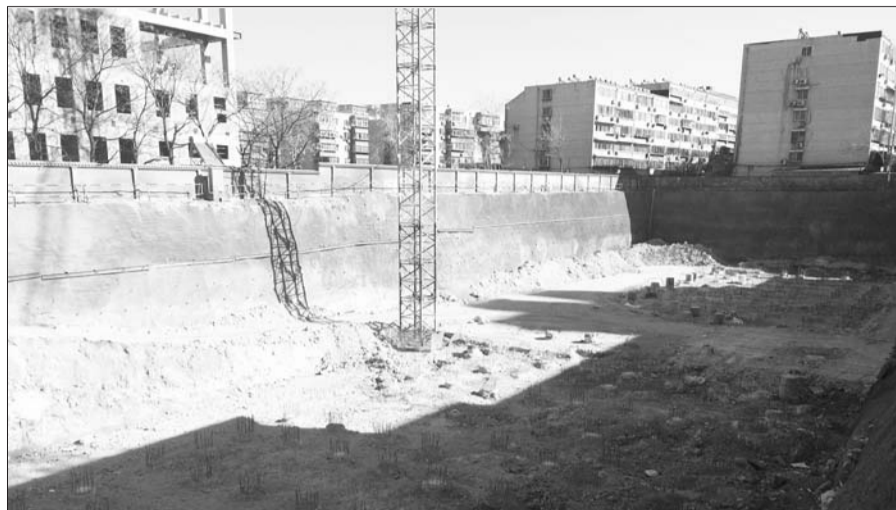
山师北街8号院施工工地挖好的基坑只剩下了一堆建筑材料,停工后一片冷清。 本报记者 喻雯 摄
