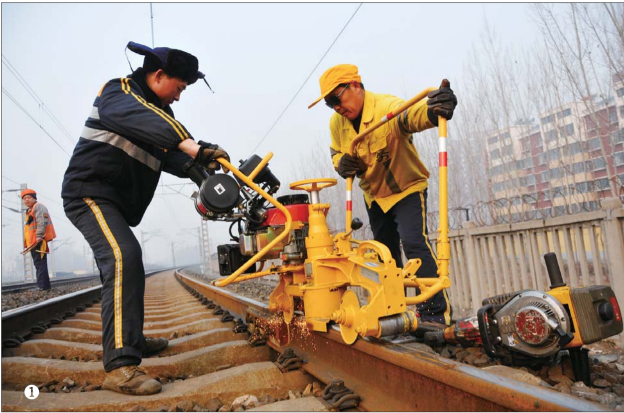
①线路工在进行钢轨打磨作业。 ②线路工为作业前做准备。 ③火车安全行驶需要前期的认真维护。 ④线路工更换钢轨夹板。
