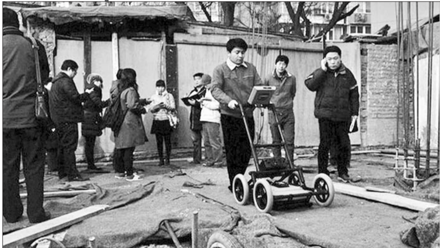
▲北京地下室私挖泛滥,执法人员用雷达探测查处。(资料片)
