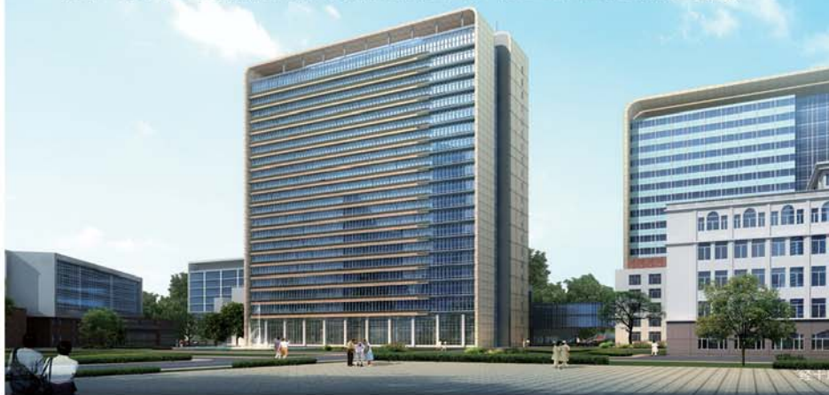
山东省千佛山医院儿科诊疗基地暨医技手术中心楼效果图
