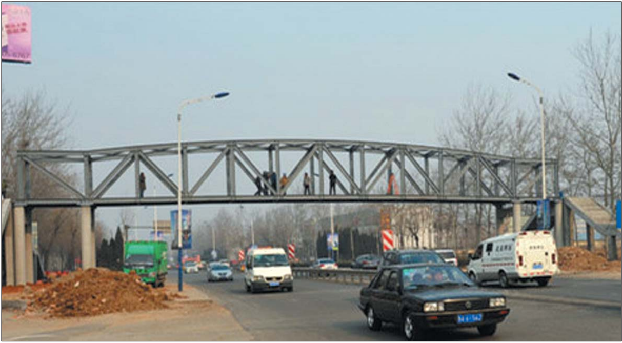
104国道马店村路口处已经架起了过街天桥框架，但一直没有建完。 市民供图
