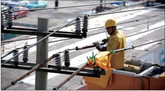
配电运检室带电作业人员正在清除隐患。
