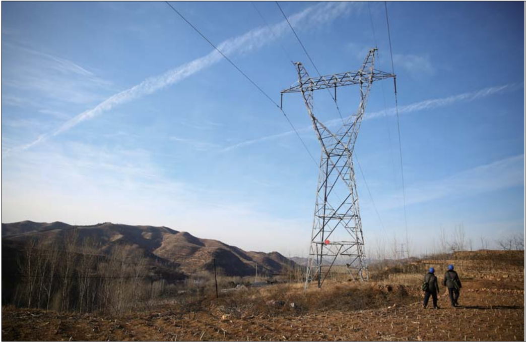
博山客户分中心牛角电工组人员正在山上巡视线路。
