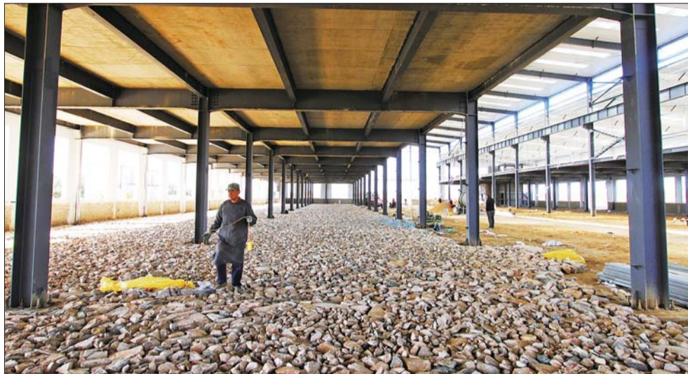
▲建设中的威海能源科技有限公司
