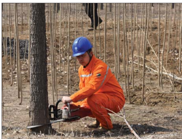
供电部门工作人员清除电力线路保护区内违章种植树木。 通讯员 崔磊 摄
