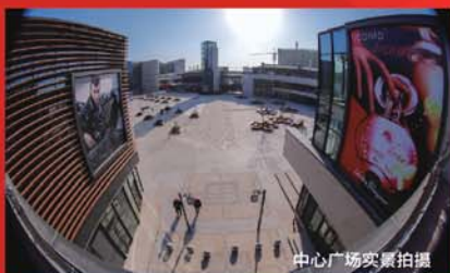
中心广场实景拍摄
